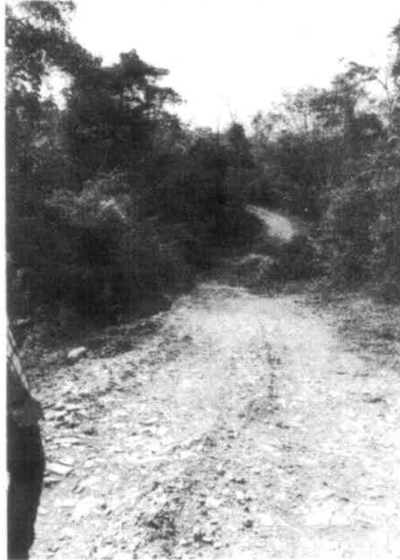
Foto 1. Vía de acceso
