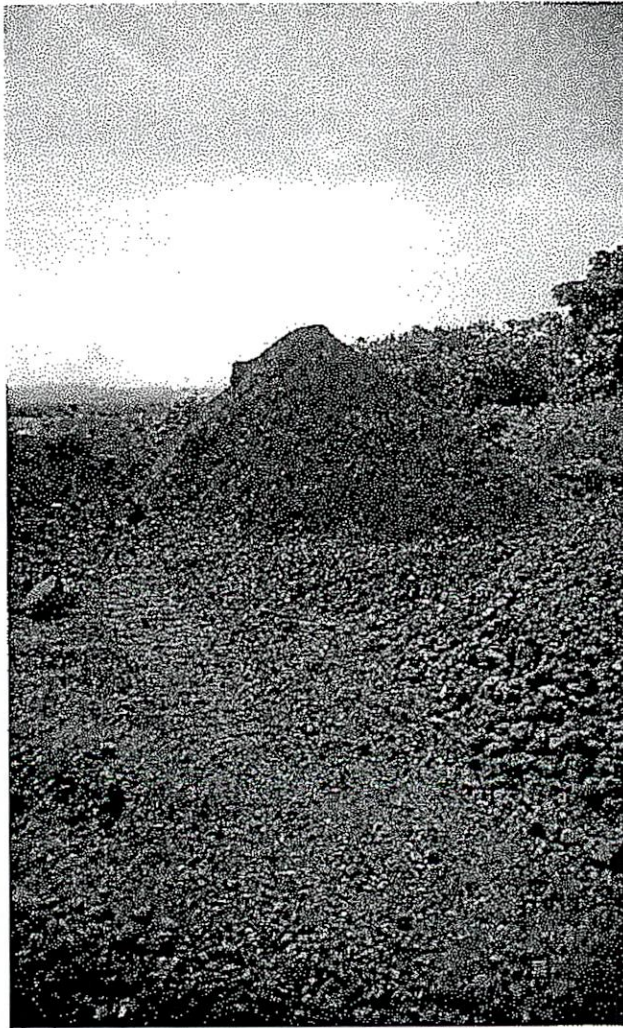
Acopio - Acopio de material
