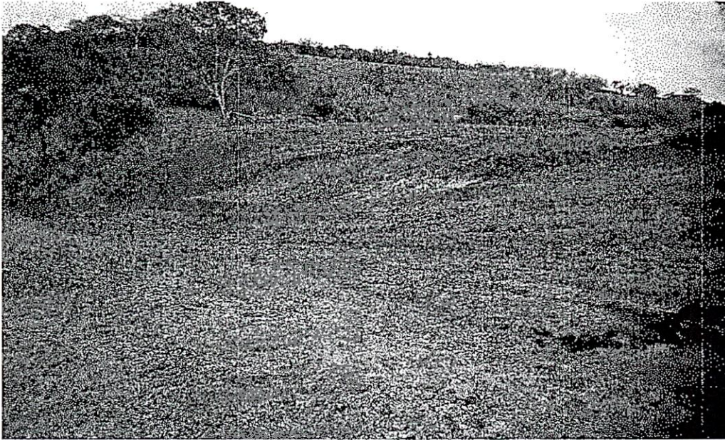
Punto de Control - Relleno realizado por Equiterra
