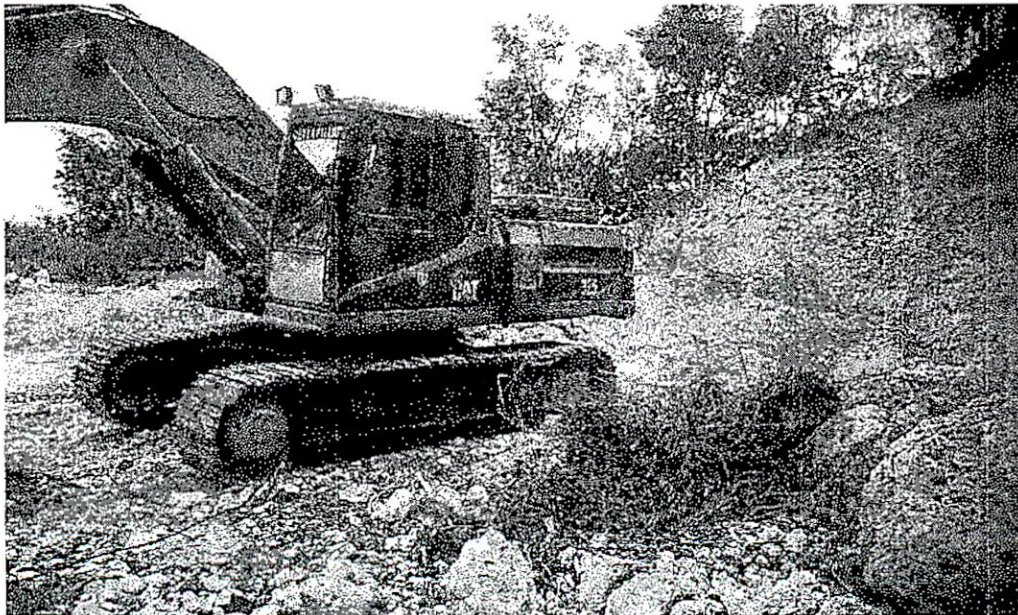
Frente de Explotación - Explotación ilegal
