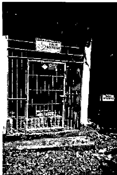
Foto 10. polvorín. Se muestra la instalación del polvorín que disponen para el almacenamiento de los materiales explosivos.
