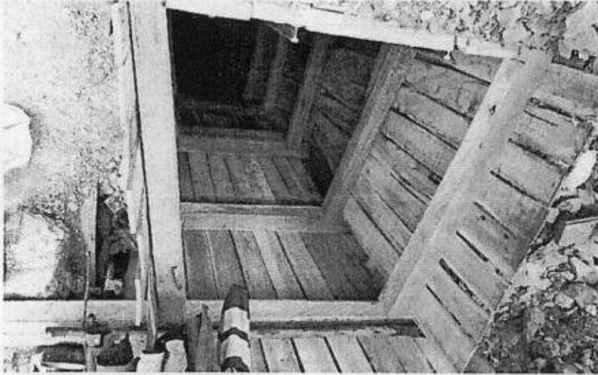
Fotografía No. 6 Bocamina de Don Javier Molano Bocamina que se ubico fuera del área del título minero HCE-081, cuneta con un inclinado de aproximadamente de 70 metros con un rumbo N40W sostenimiento en cuadro vacenota separación entre puertas cada metro con un área libre de 4 metros cuadrados. Coordenadas N1072469,0, E 1041325,0, Alt 2845 m.s.n.m.
