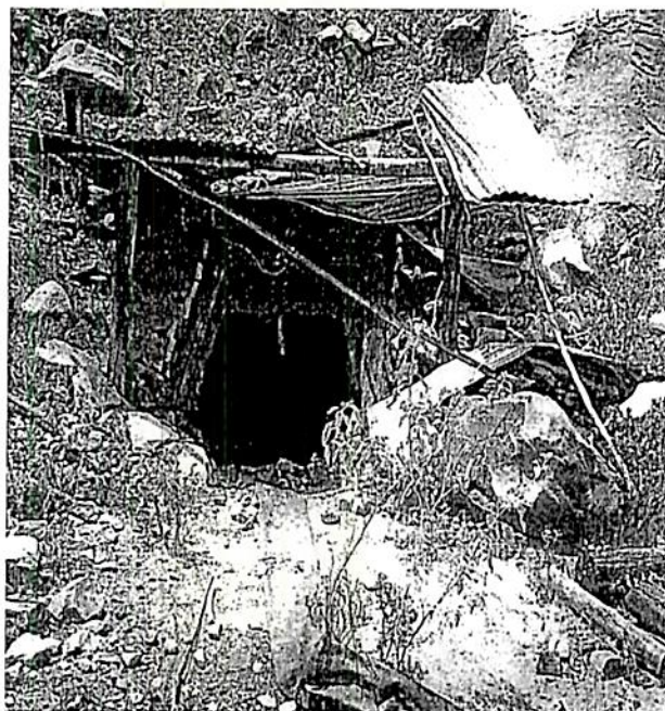
Foto 11. Bocamina X - Observaciones: Inactiva
