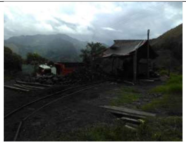
infraestructura superficie Mina San Eduardo
