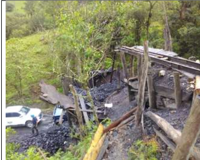
Tolva 25 ton mina "La Sierra"
