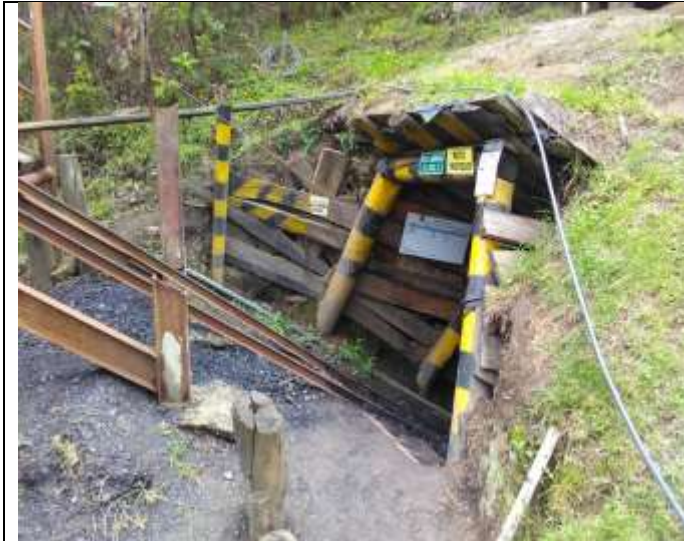
Bocamina "El Sol 2", la cual esta comunicada con labores mineras subterráneas de la Mina "La Sierra"
