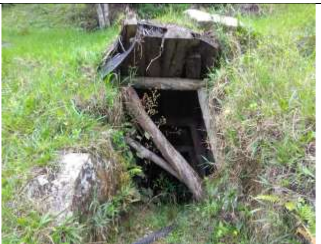
Bocaviento Mina "San Eduardo"
