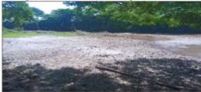
Fotografía No. 4. Frentes de explotación allegado por los solicitantes
