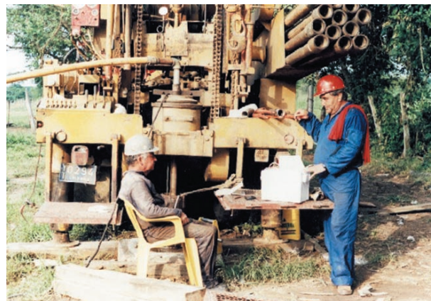
Detalle de un equipo de perforación autotransportado. Rivera, Huila. (Foto: Luis C. Ospina, 2000).
